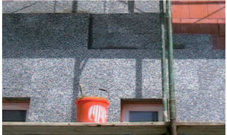
Abbildung 2: Erste Lage Dämmstoffschicht verdübelt (je nach Untergrundanforderung); bei neuwertigen Untergründen, beispielsweise Mauer- und Hochlochziegel gemäß ÖNORM B 3200, „Mauerziegel – Anforderungen, Prüfungen, Klassifizierung und Kennzeichnung – Ergänzende Bestimmungen zur ÖNORM EN 771-1“, nicht erforderlich (siehe Seite 16 und Seite 19)
