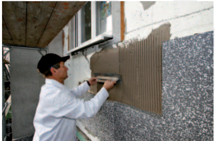
Abbildung 4: Zweilagige Verarbeitung bei der Sanierung eines bestehenden Wärmedämmverbundsystems (WDVS). Schadhafte Deckschicht wurde gestrippt (d.h. die alte Putzschicht entfernt), die neue zusätzliche Dämmstoffschicht wird vollflächig auf die bestehende Dämmstoffschicht aufgebracht.
