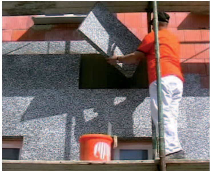
Abbildung 3: Zweite Lage Dämmstoffschicht wird auf ein vollflächiges Kleberbett aufgebracht
